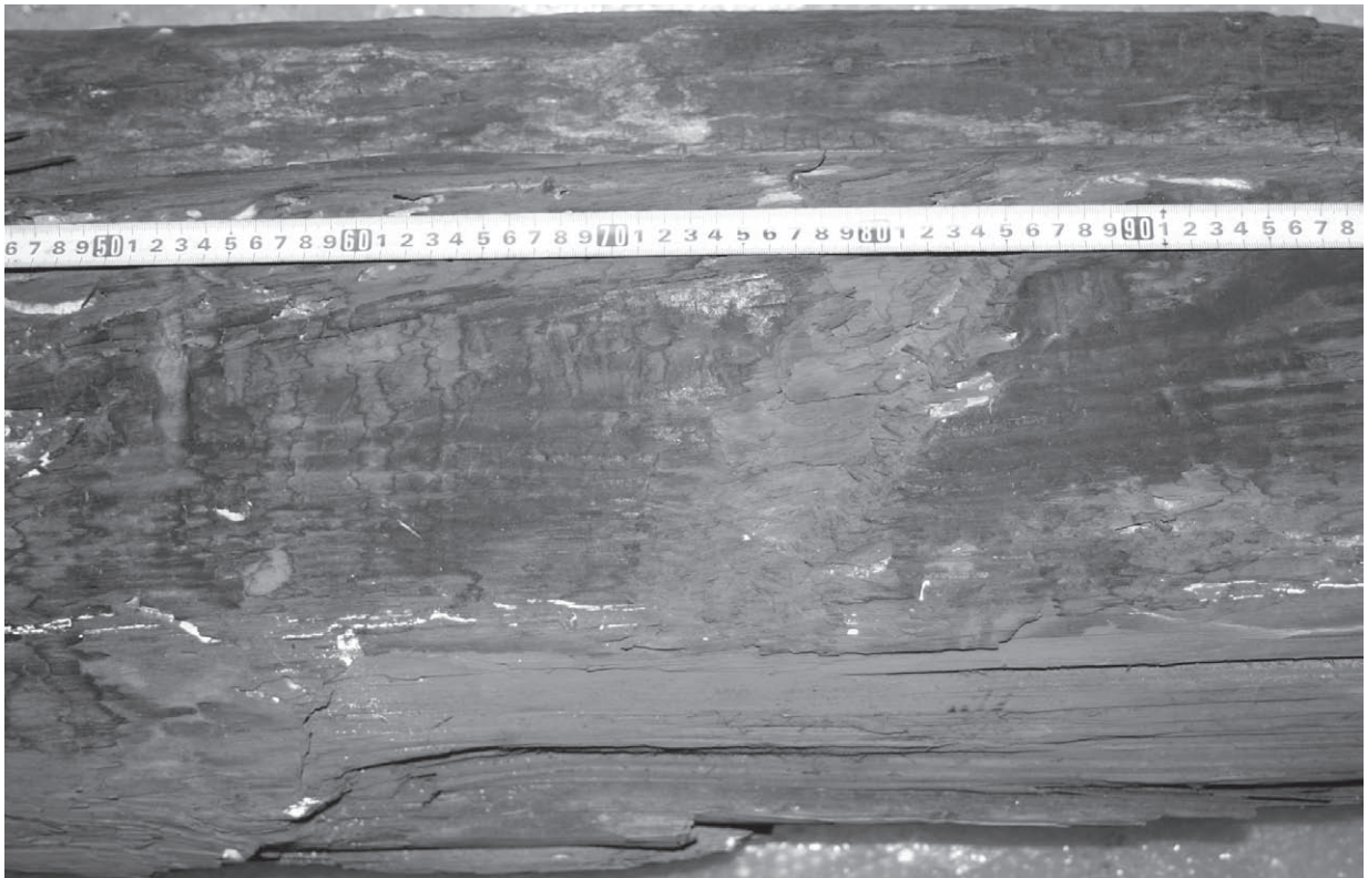
Figure 7.9 火熱による一部炭化箇所 (写真: 柏木)。
